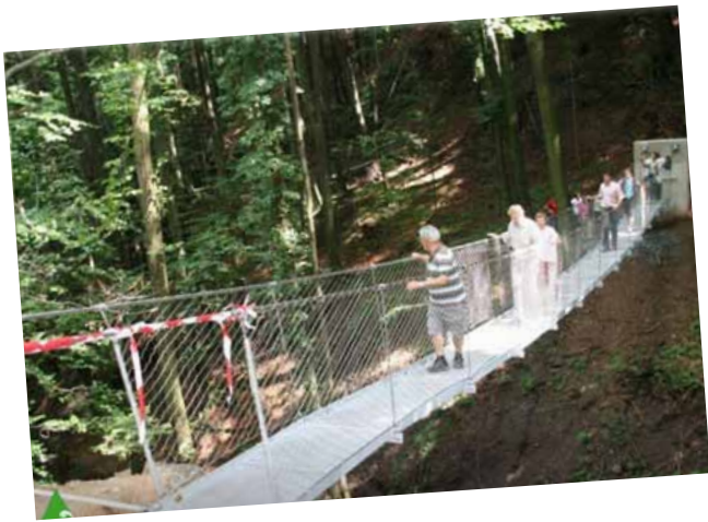
Bau der Altenbachklamm
