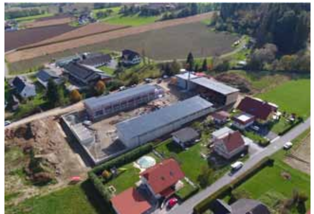
Neuer Bauhof mit Fernwärmeheizwerk
